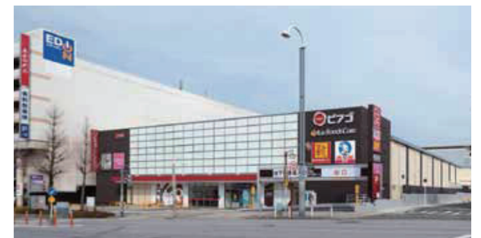
ピアゴラフーズコアアラタマ店改修後 5階建ての既存店舗を3層減築、リノベーション
