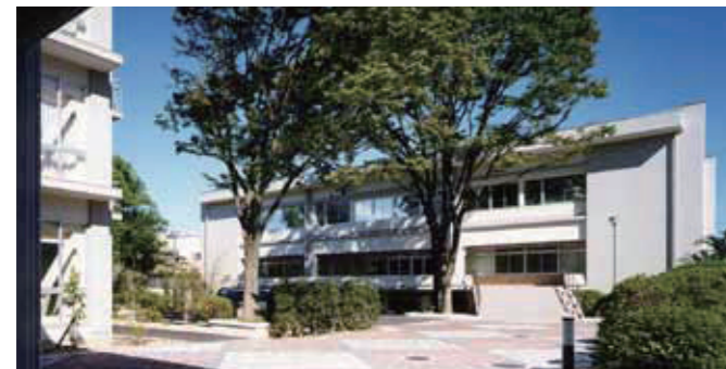
法人本部棟改修後 元大学学生会館の3、4階部分を減築し、改修した
