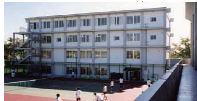
クラブハウス棟 「カメラ」改修後 元大学教室棟の東・西側の一部を減築し、耐震改修を行い部室にコンバージョン
