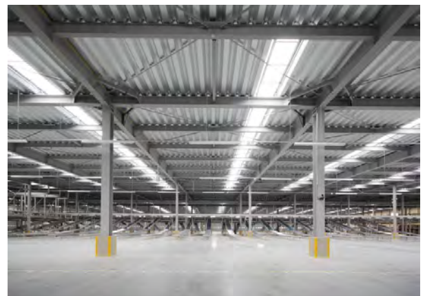
■ 荷捌き場内部 (均斉度の高い明るい室内となった)
